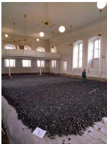
Aufbringen des Glasschotters
