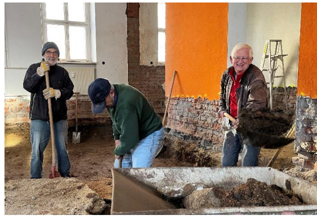
ehrenamtlicher Bau-Einsatz im November 23 (P. Vogt)
